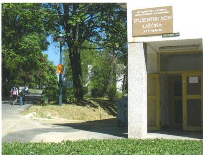
Dom građen na kraju četrdesetih i početku pedesetih prošloga stoljeća danas traži hitnu obnovu
